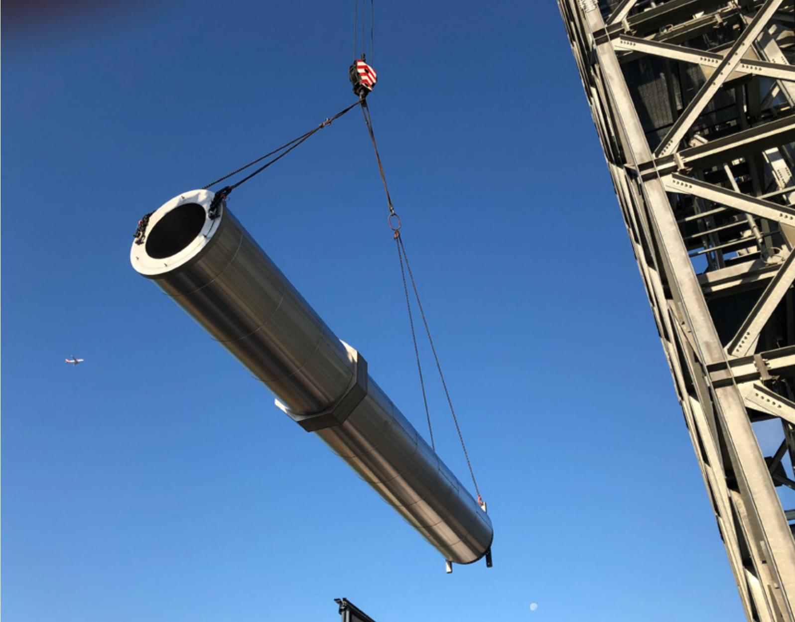
Ciascuno dei due sistemi fumari è stato dotato inoltre di un silenziatore assorbente e risonante a doppia camera del diametro interno 1000mm e del diametro esterno 1450mm, inserito nel rispettivo canale da fumo, per poter abbattere le emissioni sonore entro i limiti consentiti, particolarmente stringenti vista la presenza del vicino ospedale.
